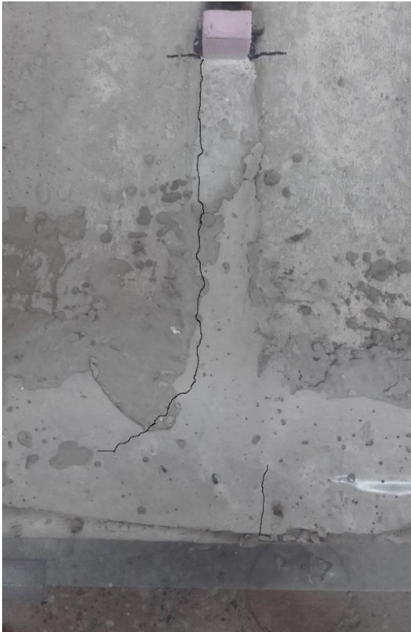
Figur 5.26: Spricka i fog 3 dragen sida. Närmaste upplaget är placerat nedanför bilden till vänster.
