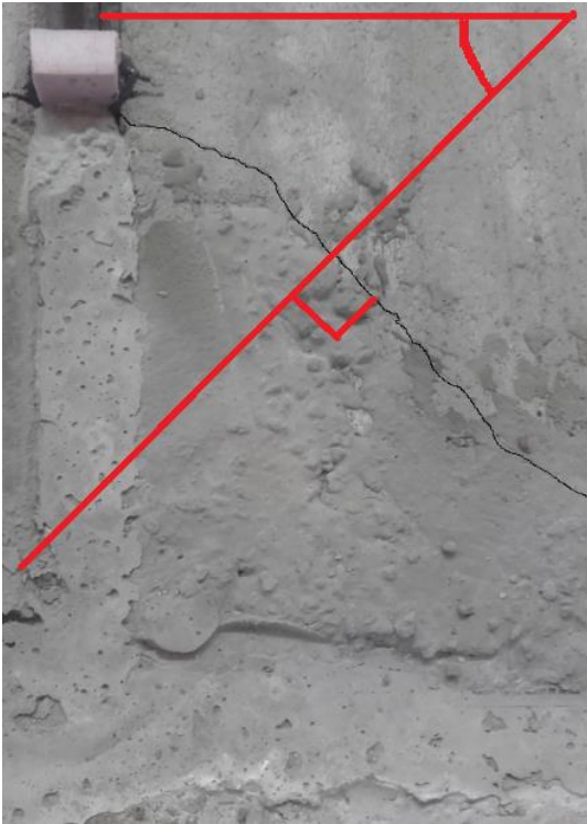
Figur 5.27: Sprickbildning och dragspänningar i fog 2, tryckta sida. Domkraften ansluter nedanför bilden till höger.
