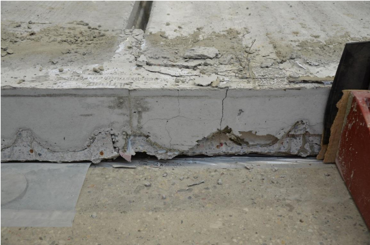
Figur 5.32: Sprickbildning mellan håldäck och igjutning.
