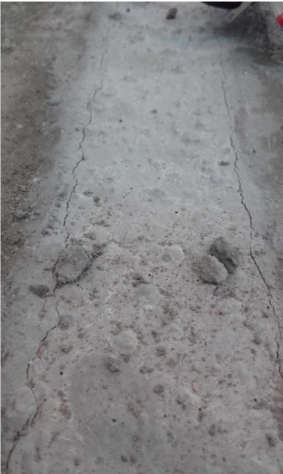
Figur 5.16: Sprickor efter gjutning över fog 2.
