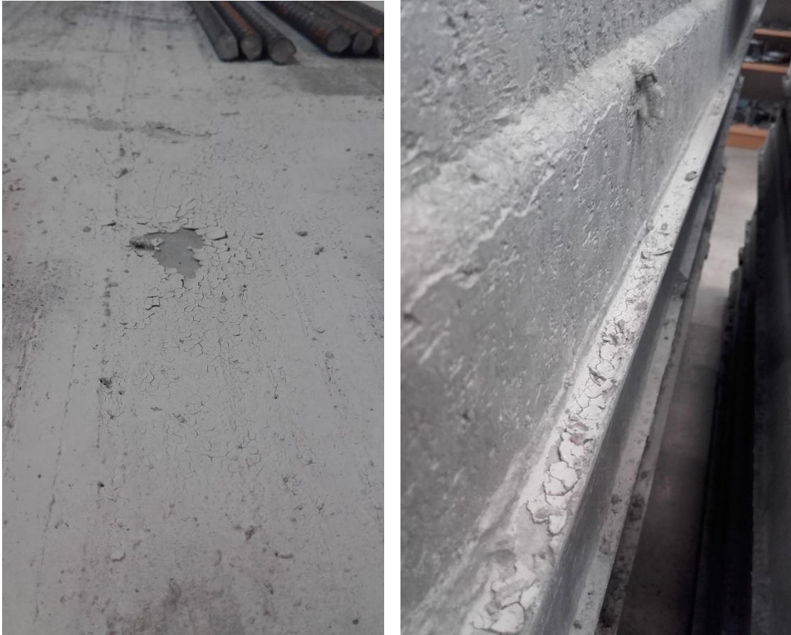
Figur 4.1: Gjuthud uppe på och i fogen på en håldäcksplatta.
