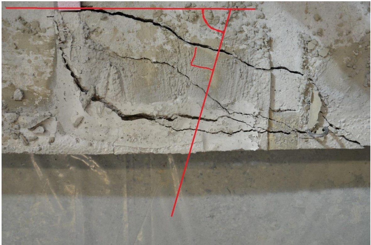
Figur 5.33: Sprickbildning i fog 1 tryckt sida, domkraft ovanför till vänster.
