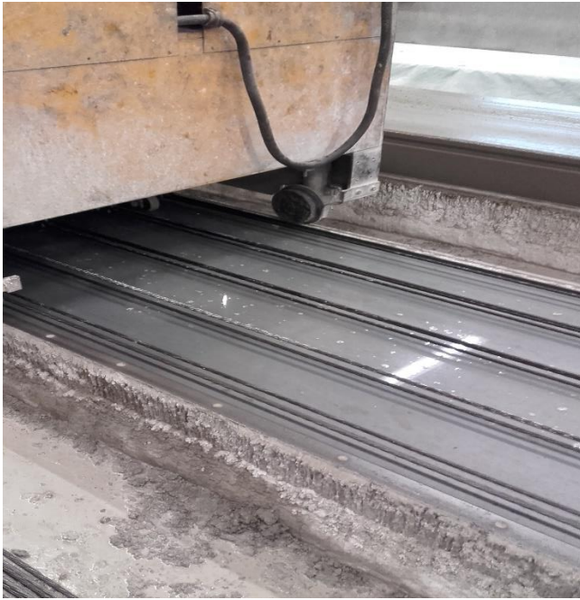
Figur 2.3: Gjutmaskinen och de förspända linorna på formen.
