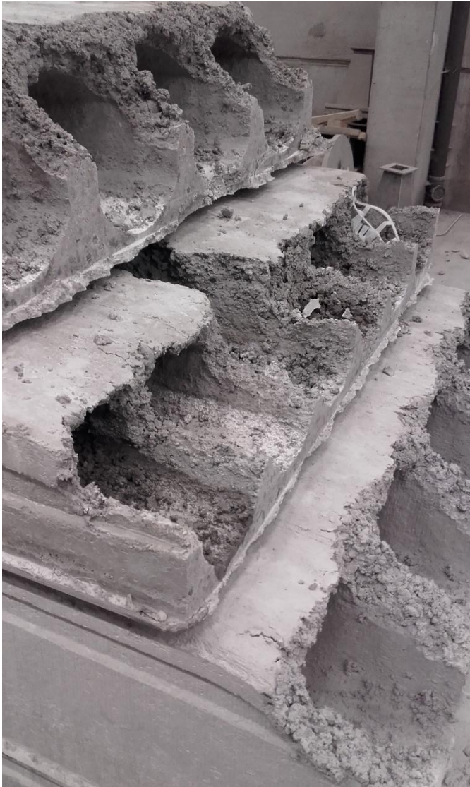
Figur 2.5: K-ände – ursparing som efter montering fylls med längsgående dragbandsarmering och betong.
