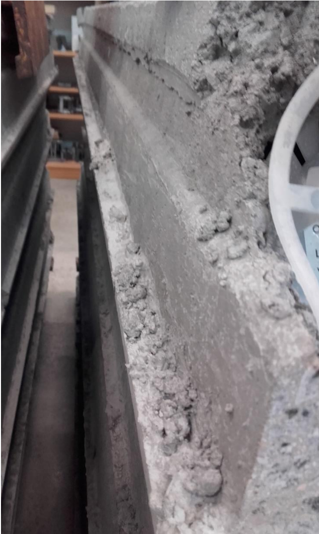
Figur 4.2: Smuts, lösa partiklar och ballast i fogen på en håldäcksplatta.
