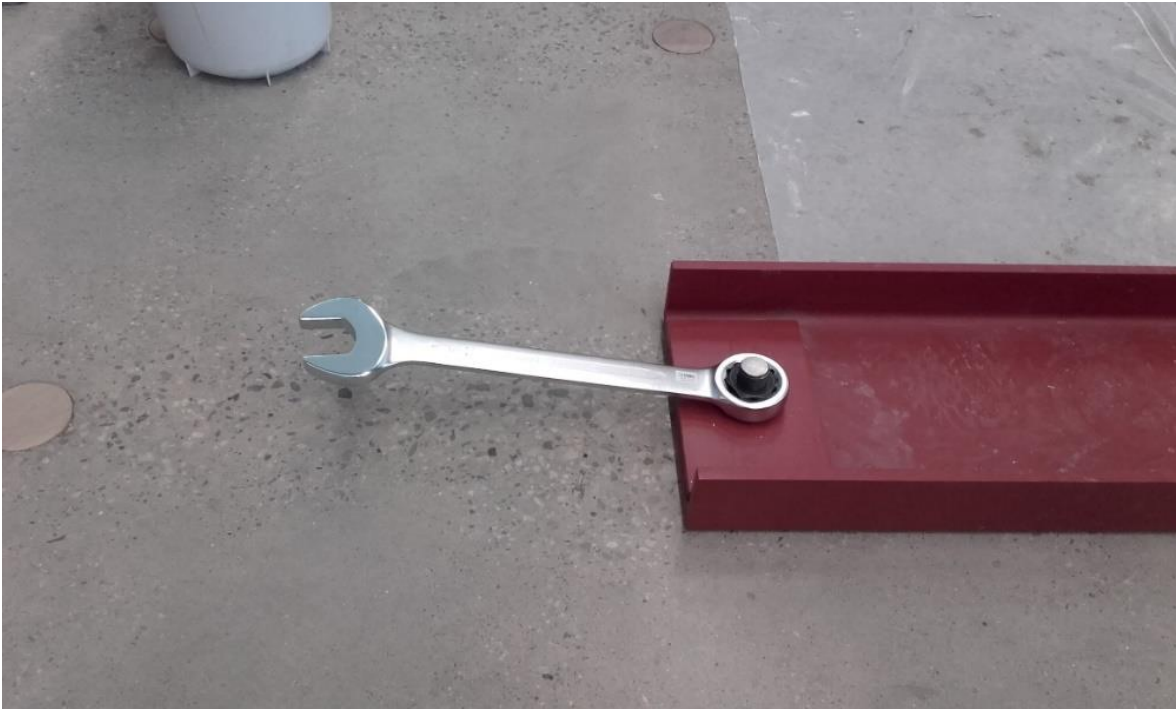
Figur 5.8: Stålprofilens infästning mot betonggolvet.
