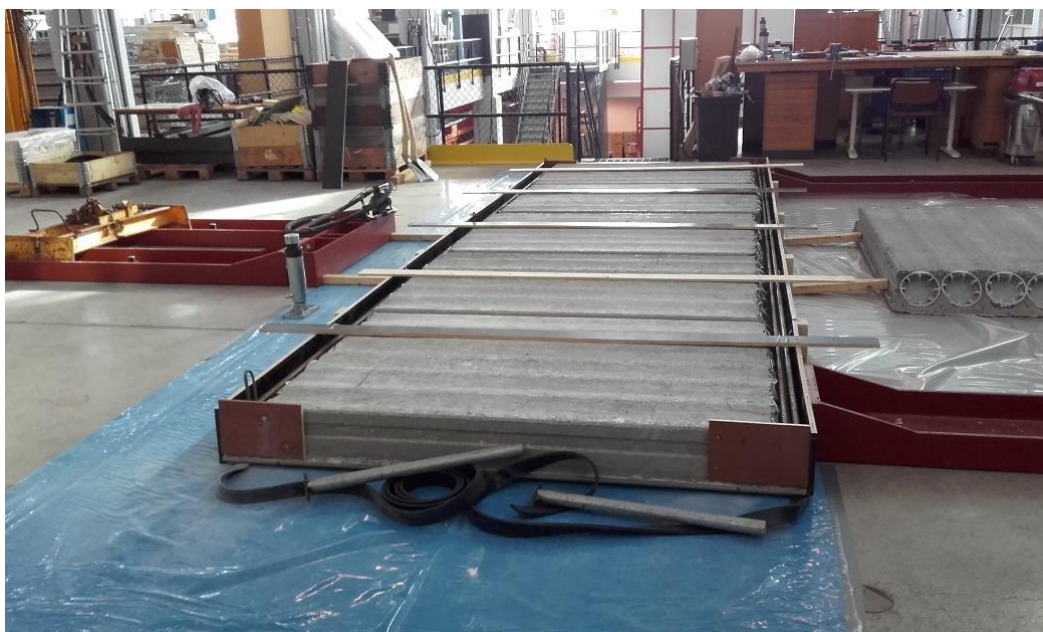
Figur 5.10: Formens utseende före gjutning.
