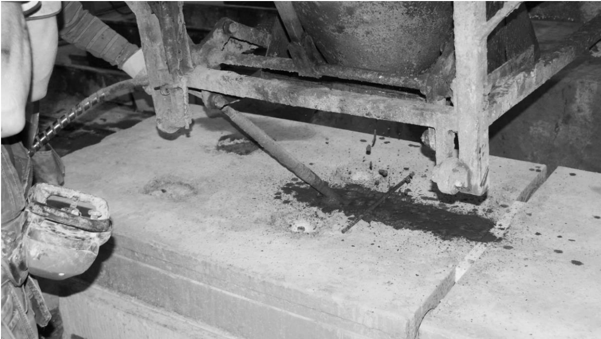
Figur 5.10: Igjutning och vibrering.
