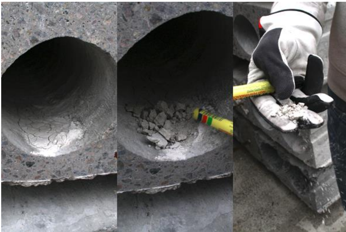
Figur 4.1: Närvaro av cementhinna i HD/F-kanal.
