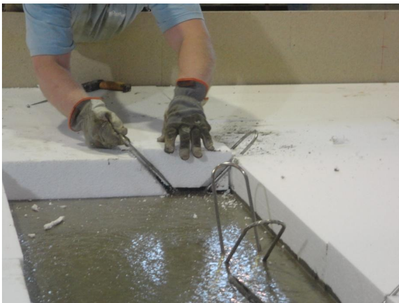
Figur 13. Tillskärning av cellplasten.
