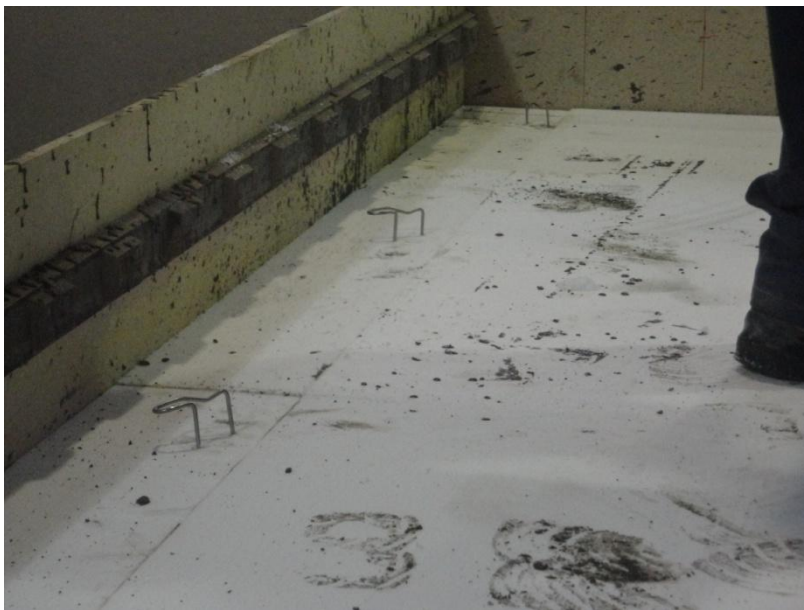
Figur 14. Förbindelsebyglar placerade genom cellplasten i den färska betongen.
