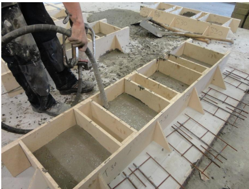
Figur 43. Vibrering av underskikt.
