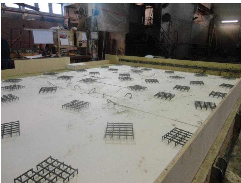
Figur 15. Distanser utplacerade på cellplasten.
