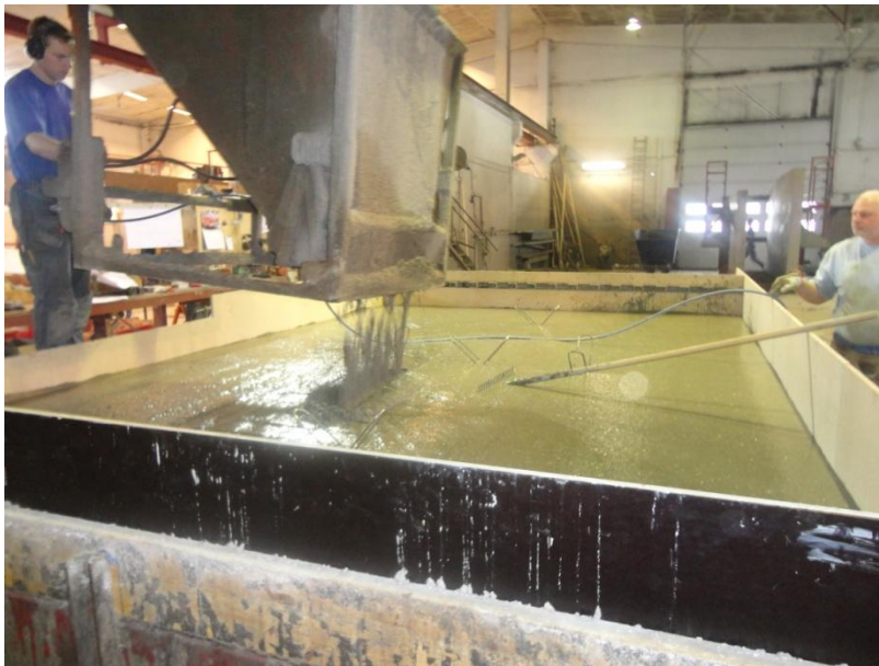
Figur 12. Gjutning av ytterskiktet.
