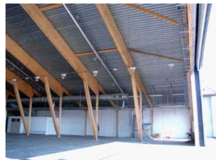
Skråstiverne var underdimensionert og kan ha vært tilleggsårsak til skaden.
