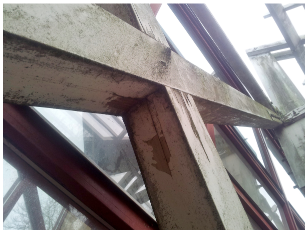
Figur 2.4: På de nedre skuggade sidorna av strävorna kan sprickor urskiljas vilka begynner vid urtagens hörn.
