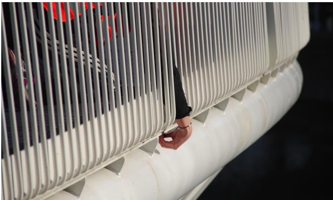
Figur 8.3 Enaxiell accelerometer monteras på bron
