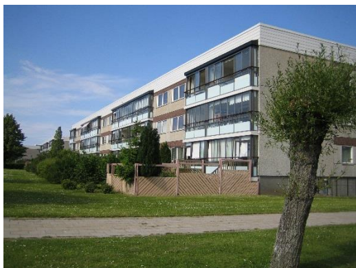
Figur 2.1: Lamellhus i Lindeborg, Malmö [5].
