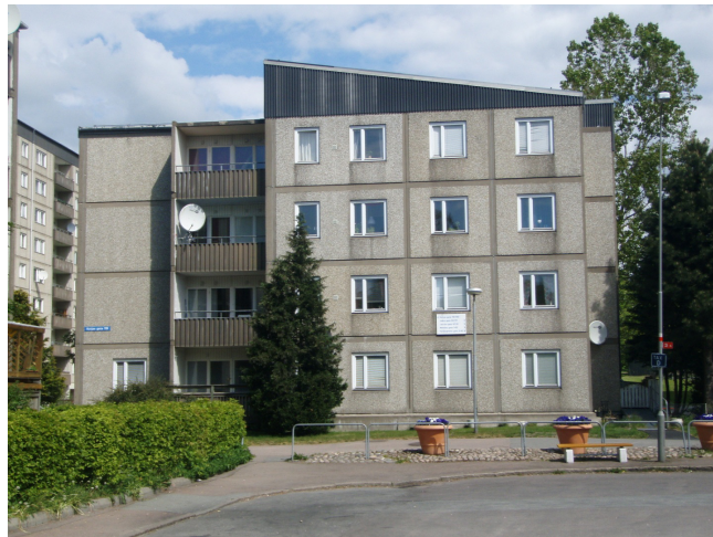
Figur 2.8: Katjas Gata 119 före renovering. [8]
