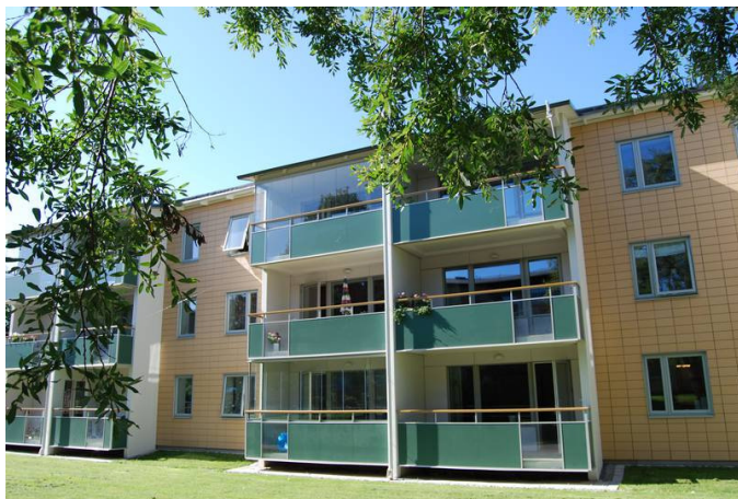
Figur 2.12: Brogården efter renovering. [47]
