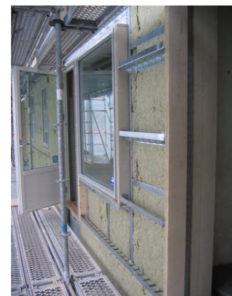
Figur 2.11: Pågående montering av stålreglar och mineralull. [29]
