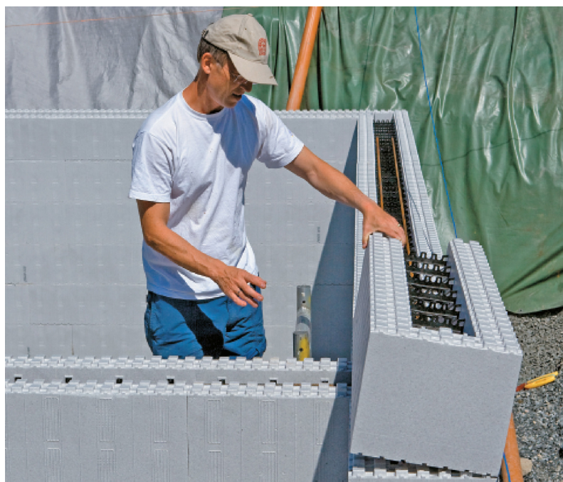
Figur 4.1: Montering av ”Dorotherm 350”- block. [21]
