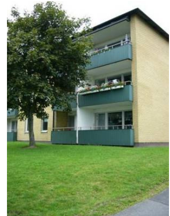
Figur 2.10: Brogården före renovering. [29]
