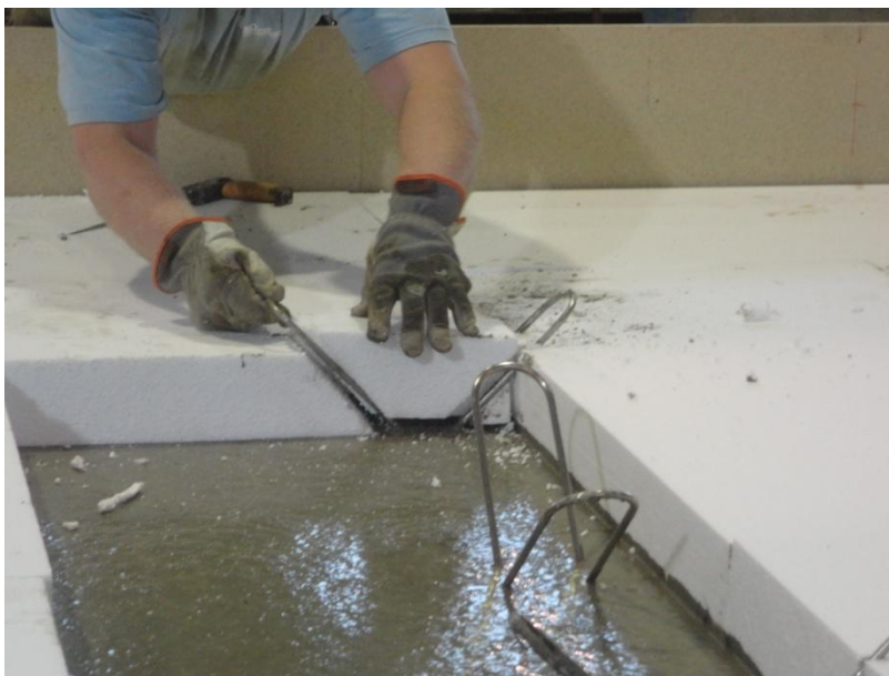
Figur 13. Tillskärning av cellplasten.
