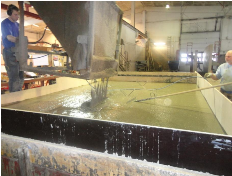
Figur 12. Gjutning av ytterskiktet.
