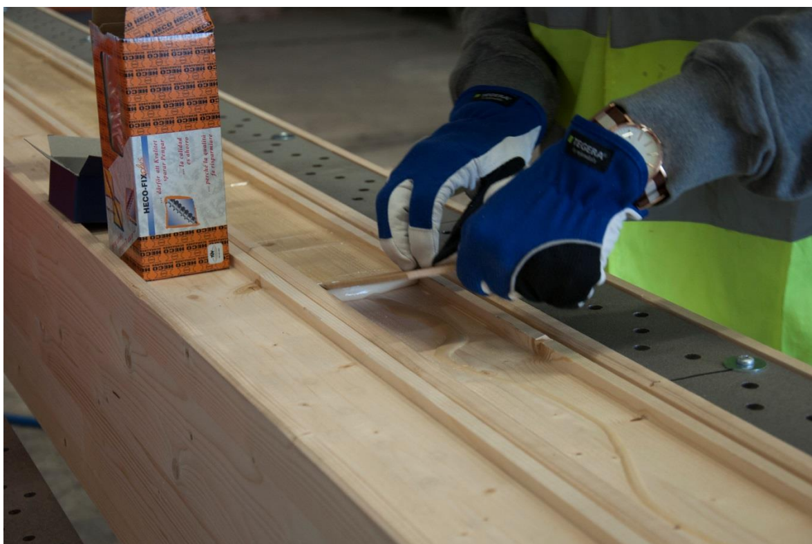
Figur 6.9 – Jämn fördelning av limmet på träytan.
