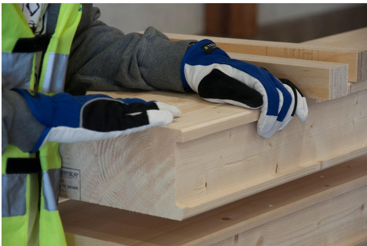
Figur 6.4 – Urfräsning till stålförstärkningen (80x10 mm).
