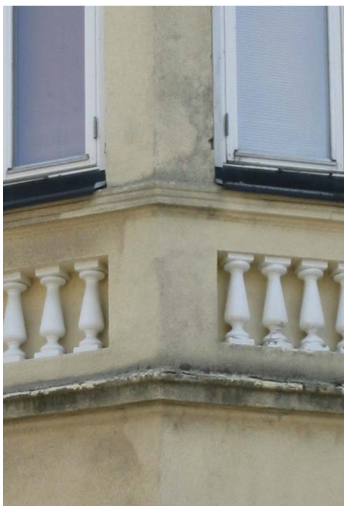
Figur 52. (Ovan) Närbild på sydvästra hörnet. Visar tydlig påväxt av något som kan liknas vid mossor.
