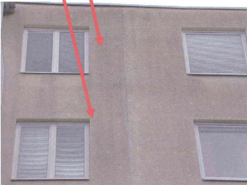
Figur 35. Termografering av fasad 2.
