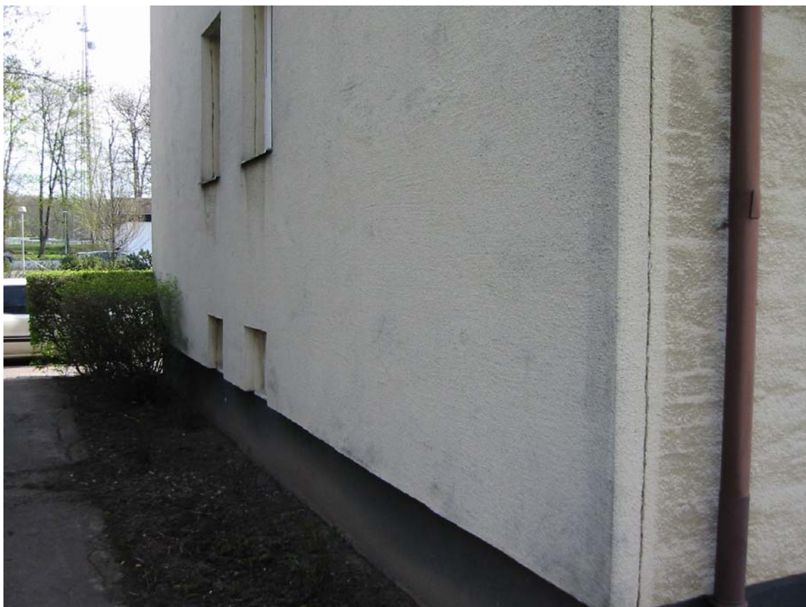
Figur 58. (Ovan) Norrfasad med underlig missfärgning vid nordvästra hörnet.
