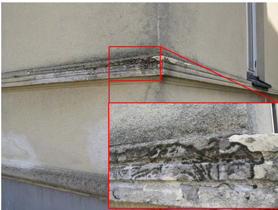
Figur 52. (Ovan) Närbild på sydvästra hörnet. Visar tydlig påväxt av något som kan liknas vid mossor.
