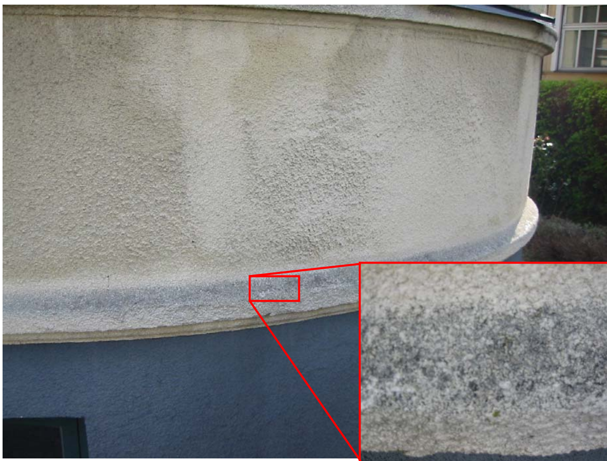
Figur 43. Detaljbild på angripen fasadkant.
