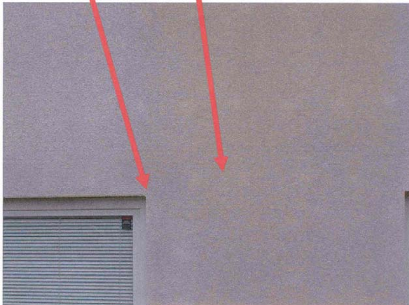
Figur 36. Termografering av detalj på fasad 2.
