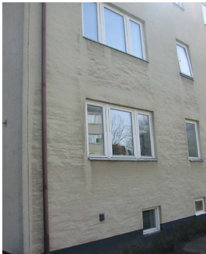
Figur 58. (Ovan) Norrfasad med underlig missfärgning vid nordvästra hörnet.
