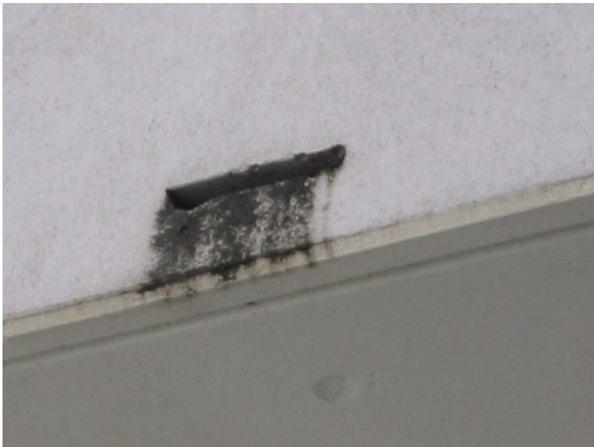
Figur 18. (Ovan) Närbild på ett av de angripna dräneringshålen. Här kan ses en tydlig påväxt som påminner om antingen mögel eller alger.
