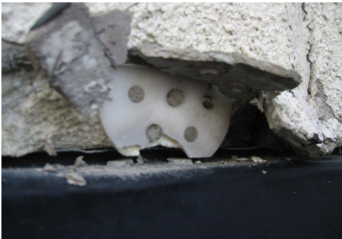
Figur 29. Fästnanordning för cellplast.
