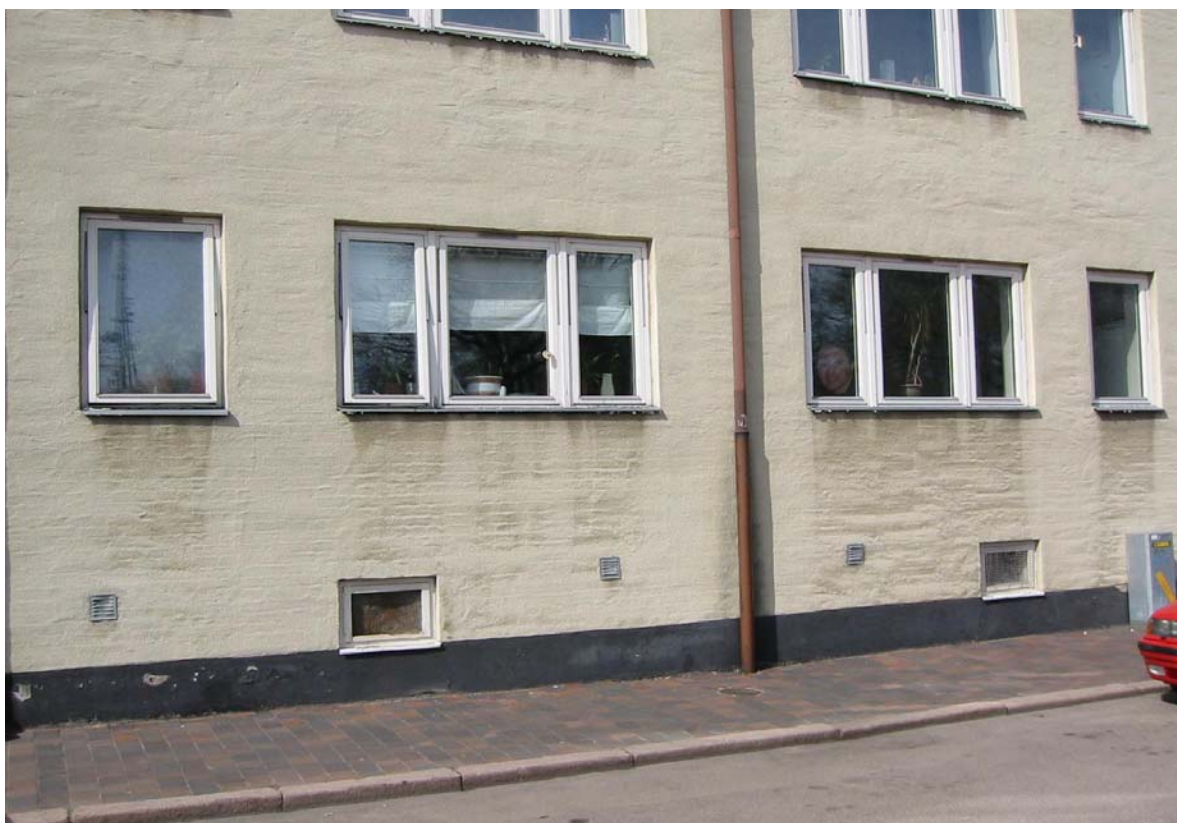
Figur 57. Fasad mot Mellersta-Stenbocksgatan 31
