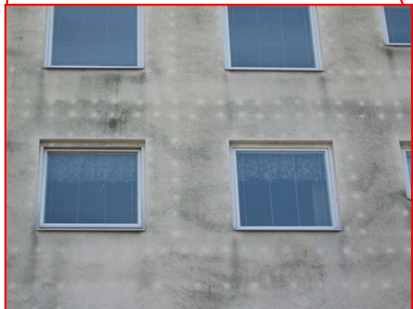
Figur 31. (Höger) Tydlig påväxt och effekt av köldbrygga.
