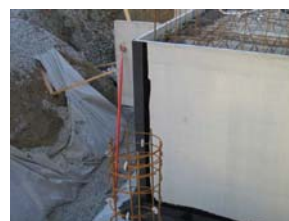
Bild 5.1. Bilden visar hur elementskarvarna tätas.
