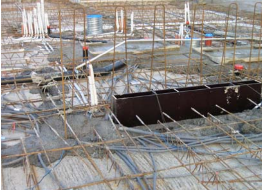
Bild 5.3. Bilden visar hur installationerna placeras uppe på plattbärlagret innan gjutning.
