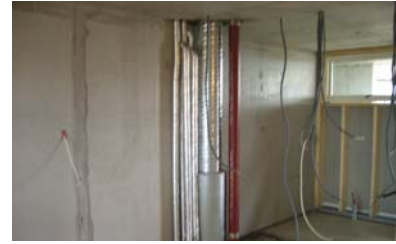
Bild 5.2. På bilden ses ett av de punktvis placerade schakten.
