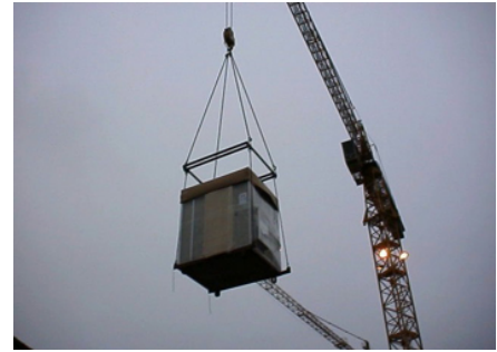
Bild 7.1. Visar hur ett prefabricerat badrum lyftes med hjälp av lyftok. [20]
