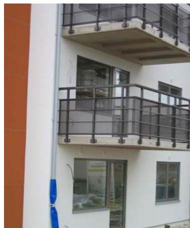
Bild 6.3. Här ses de utkragade balkongerna. Se även figur 7.6
