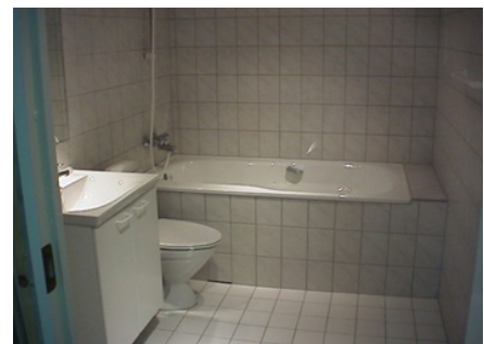
Bild 7.2. Prefabricerat badrum sett inifrån. [20]
