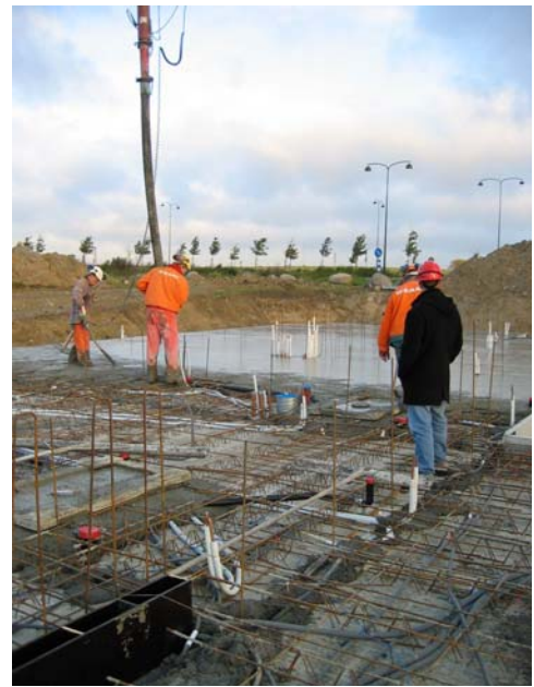
Bild 6.1. Gjutning av bjälklag.
