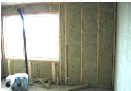
Bild 6.2. Utfackningsvägg med isolering sedd inifrån.
