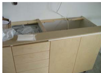
Bild 6.4. Köksinredning utan förborrade hål för skåps- och lådhandtag.
