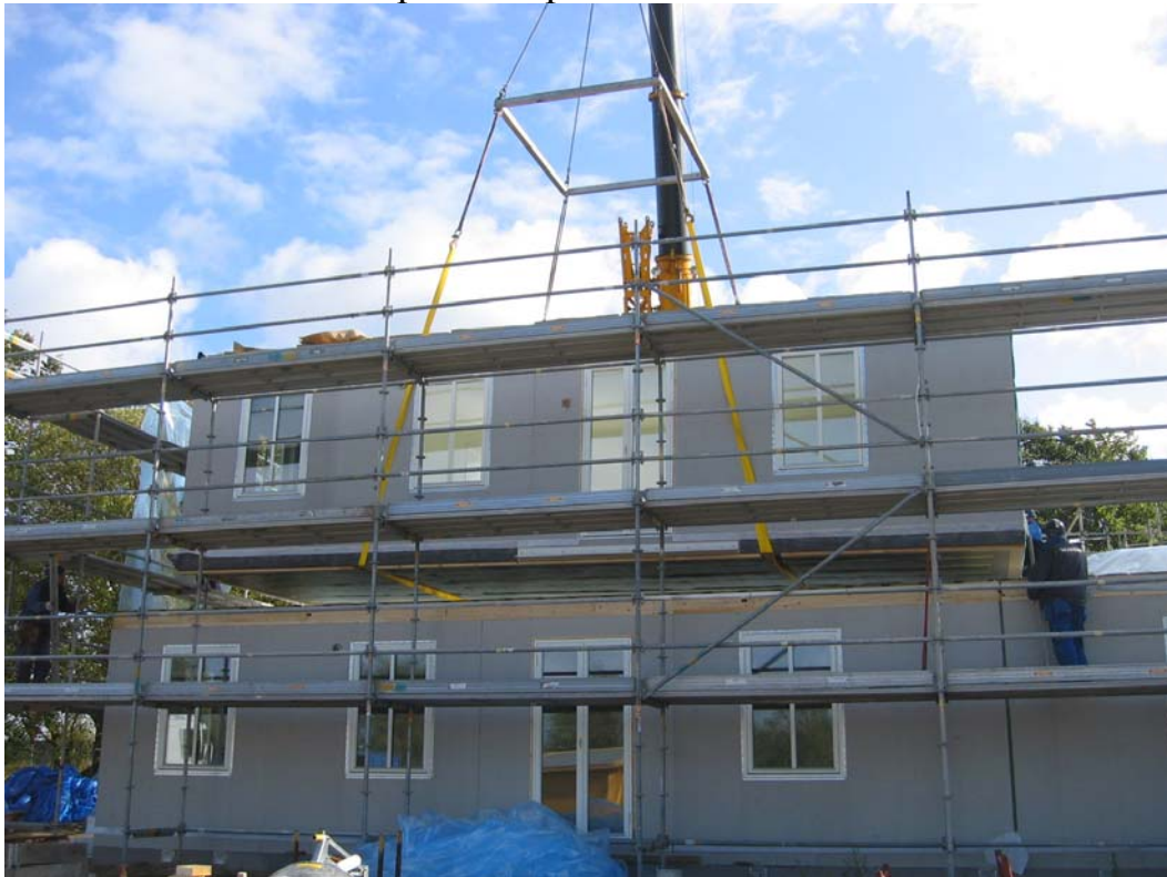
Bild 26. Montering av volymelement.
