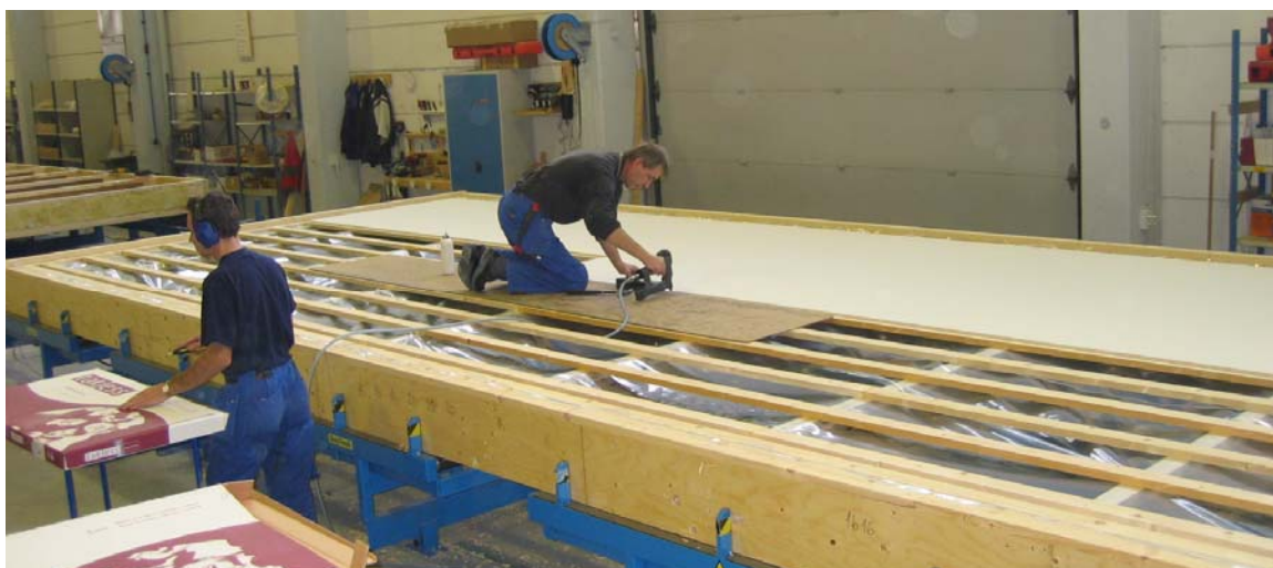
Bild 23. Montering av takgips.
