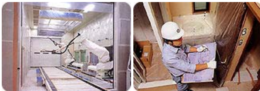
Bild 16 & 17. Sprutmålning och kontroll av modul. (Sekisui Chemical, 2004)
