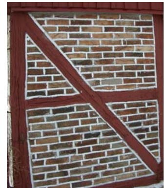
Bild 4. Murad tegelvägg mellan stolparna. Skånelänga Fjärestad.
