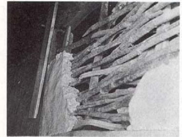
Bild 3. Uppbyggnad lerklinevägg. Så renoveras torp och gårdar, ICA förlaget.
