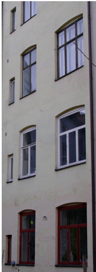
Bild 5. Fönster mot innergården, original högst upp
