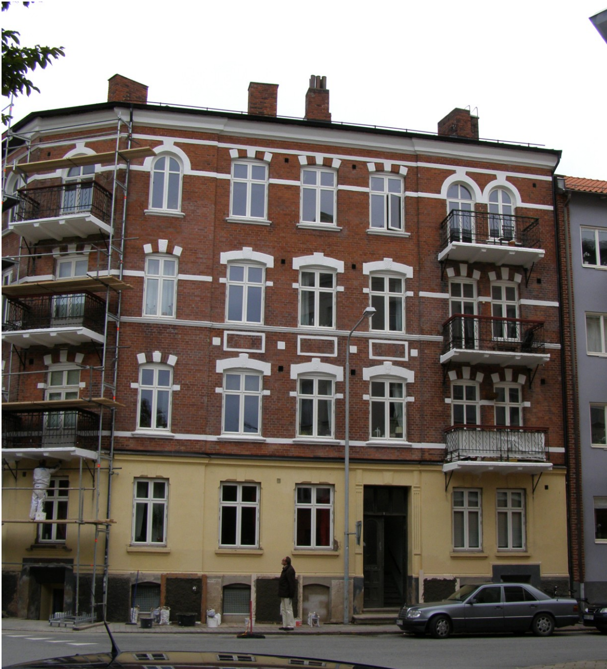
Fasad mot Bjäregatan efter fönsterbytet. Den nya kulören förändrar fasaden märkbart.
