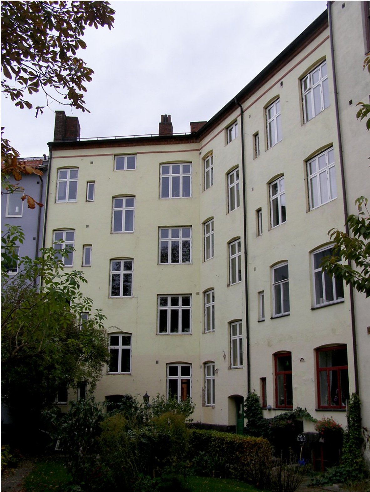
Gårdsfasaden efter fönsterbytet
