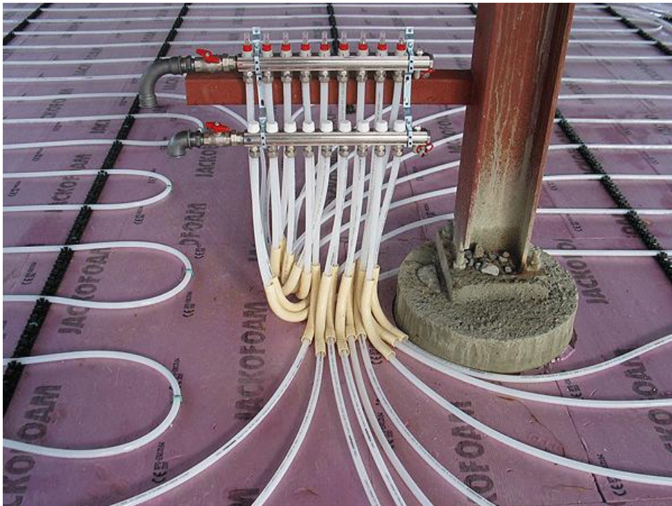
Figur 4.2 Golvvärme ingjuten i betongplatta (Gränsfors, 2012)
