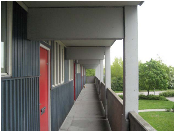
Figur 12 [ L-stöden som lyfter upp loftgångsplattorna ]
