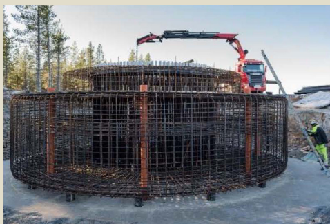
Figur 2. Armering till bergförankrat fundament
