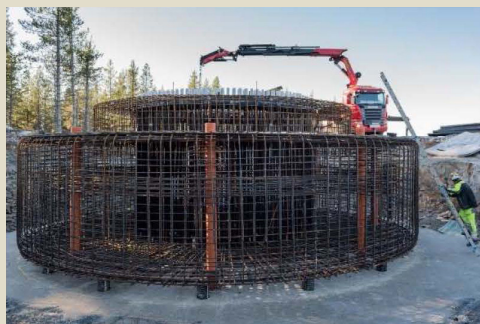
Figur 2. Armering till bergförankrat fundament
