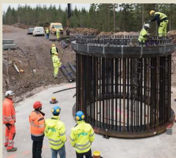
Figur 1. Bultkorg till bergförankrat fundament
