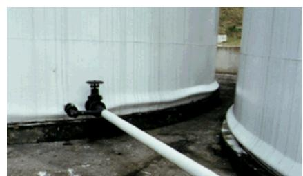
En vanlig skada på tunnväggiga stål- cisterner, utsatta för jordbävning är s k elefantfotsbuckling.
