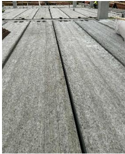
Håldäckslement innan foggjutning
