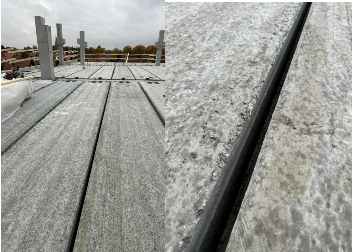
Figur 4: Håldäckselement utlagda över ett bjälklag innan foggjutning. Till vänster en översiktlig bild och till höger en inzoomad illustration över hålrummet mellan elementen i tvärriktningen.
