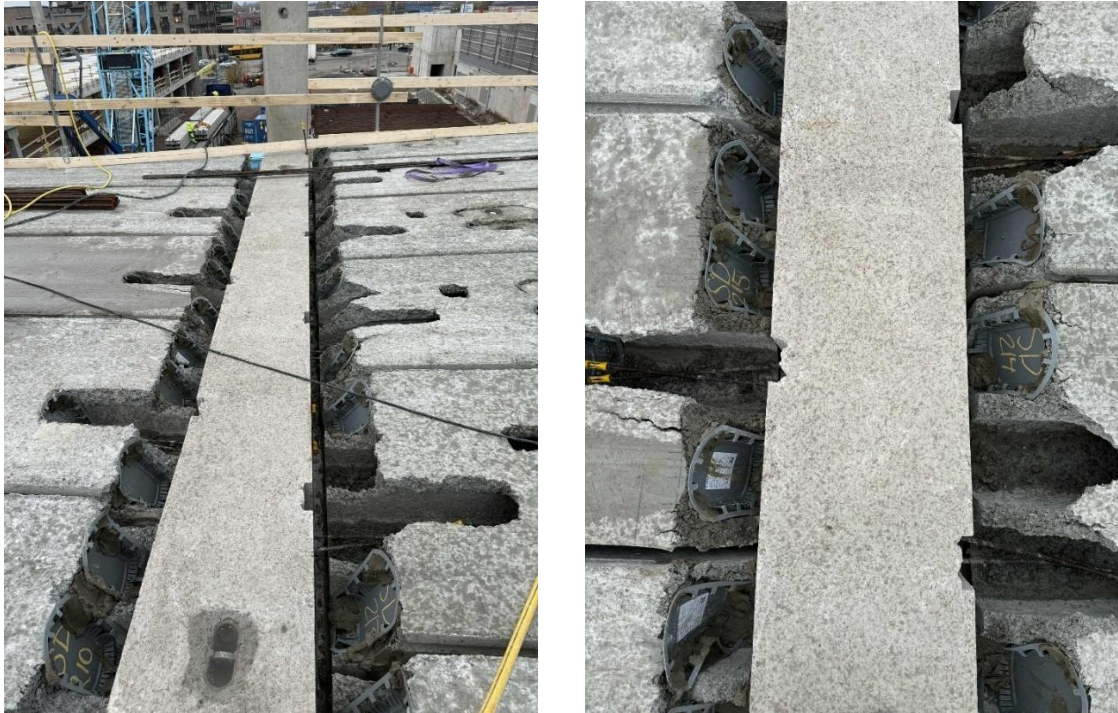
Figur 3: Bild över håldäckselement upplagda på håldäck innan foggjutning. Till vänster översiktsbild över en balk med flera element och till höger in zoomat över ett elements bredd.
