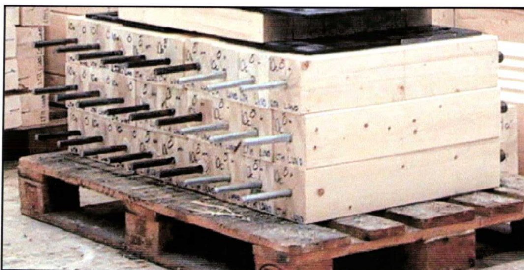
Figur 9. Förvaring av inlimmade stänger.
