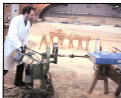
Figur 8. Applicering av gängade stänger.
